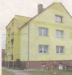
Bezvěrovští zastupitelé čekají na vyplacení dotace na zateplení této bytovky ve Vlkošově.
